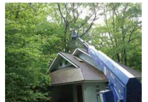
06 屋根にかかる枝木の伐採
